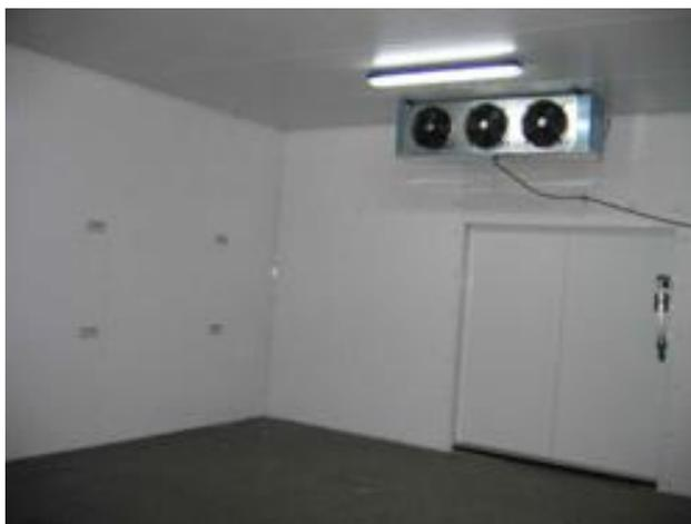
Эти холодильные камеры предназначены для охлаждения и замораживания мяса в полутушах и фасованного, рыбы целиком или брикетированной, различных полуфабрикатов,пельменей, чебуреков, овощей и фруктов и т.п. Такие камеры как правило работают в циклическом режиме при периодической загрузке и выгрузке продукции.
